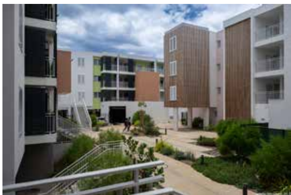
Dupleix (Le Port) - 48 logements locatifs PLS Maitre d'ouvrage : SIDR Maître d'oeuvre : Olivier Ehresman Architecture
