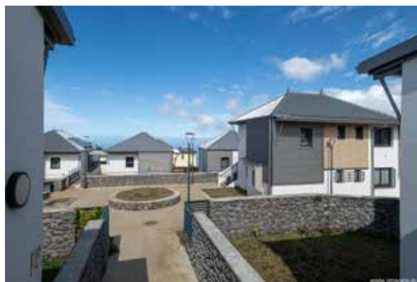
Paprika (Trois-Bassins) - 12 logements locatifs LLS Maîtrise d'ouvrage : SIDR Maître d'oeuvre : P. Ghizzo Architecture
