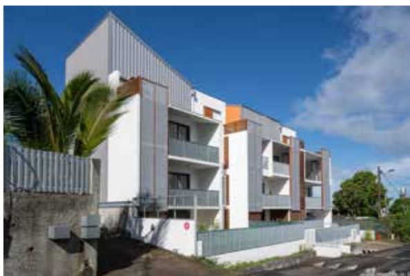
Limpopo (Sainte-Marie) - 9 logements locatifs PLS Maitre d'ouvrage : SIDR Maître d'oeuvre : Les architectes - MI de l'Eperon
